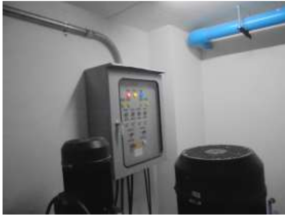
รูปที่ 25 อุปกรณ์ควบคุมความเร็วรอบมอเตอร์
